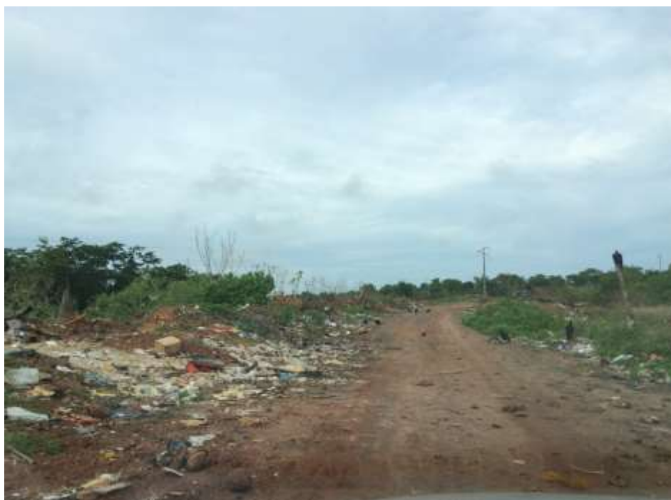
Figura 129. Área Irregular de lançamento Fonte: Prefeitura Municipal de Caxias, 2015.
