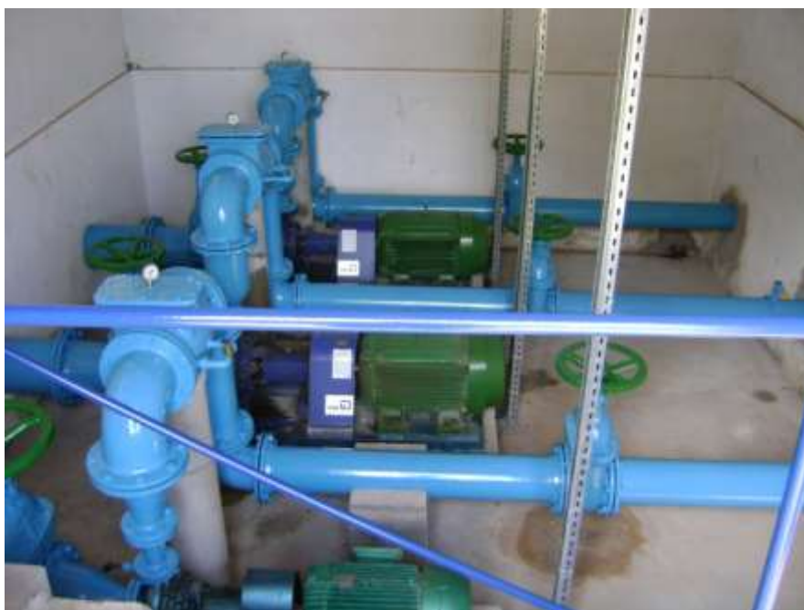
Figura 27. Conjuntos Moto-bomba
