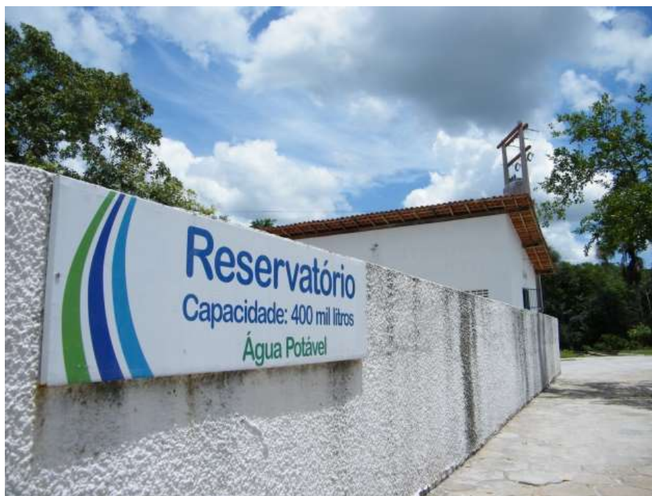
Figura 44. RAP ETA Ponte
