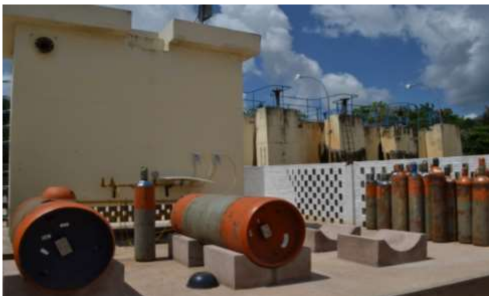
Figura 22. Casa de Cloração Fonte: ASCOM SAAE/Caxias, 2015.
