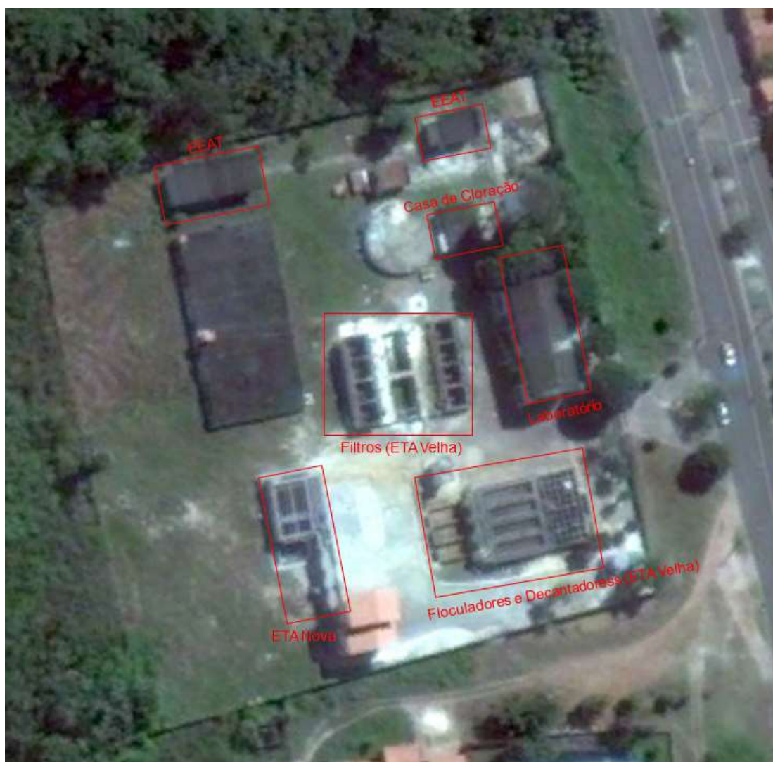
Figura 14 - Vista Geral ETA Volta Redonda
