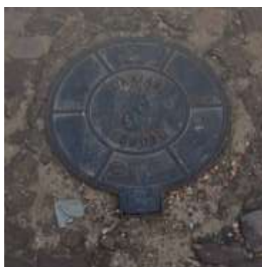
Figura 78. Poço de Visita da Rede Coletora Existente
