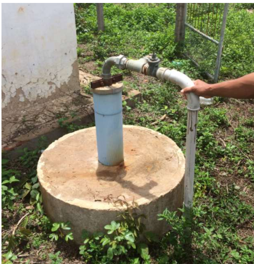
Figura 57. Poço Buenos Aires
