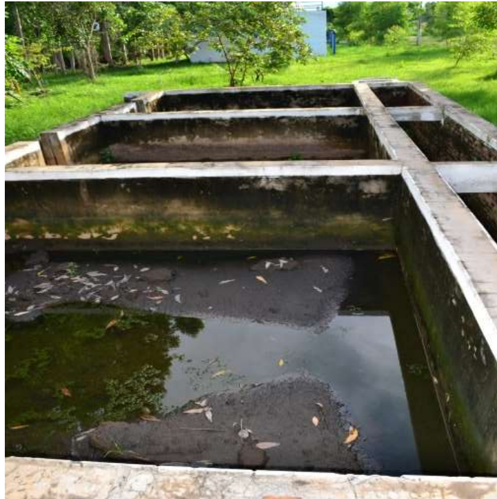
Figura 83. Leito de Secagem Fonte: ASCOM SAAE/Caxias, 2015.
