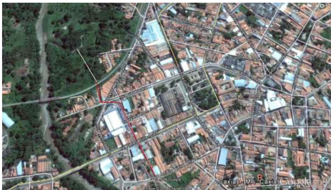
Figura 97 - Canal Rua Bom Pastor Fonte: Google Earth, 2015.
