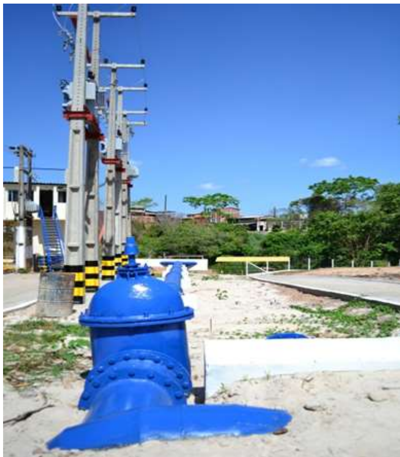
Figura 13 - Relatório fotográfico (Adutora de Água Bruta Rio Itapecuru) Fonte: Prefeitura Municipal de Caxias, 2015.
