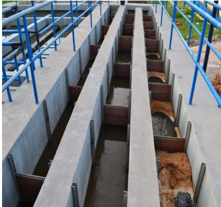
Figura 20. ETA Volta Redonda 2 - Flocladores Fonte: ASCOM SAAE/Caxias, 2015.
