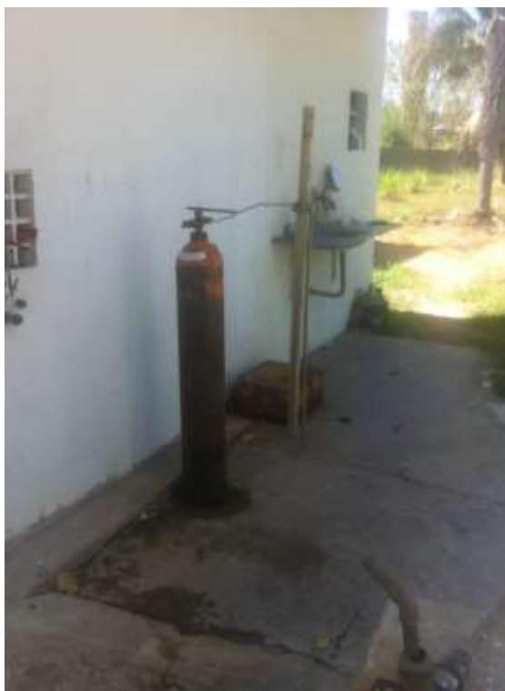
Figura 33. Casa de Cloração Fonte: ASCOM SAAE/Caxias, 2015.
